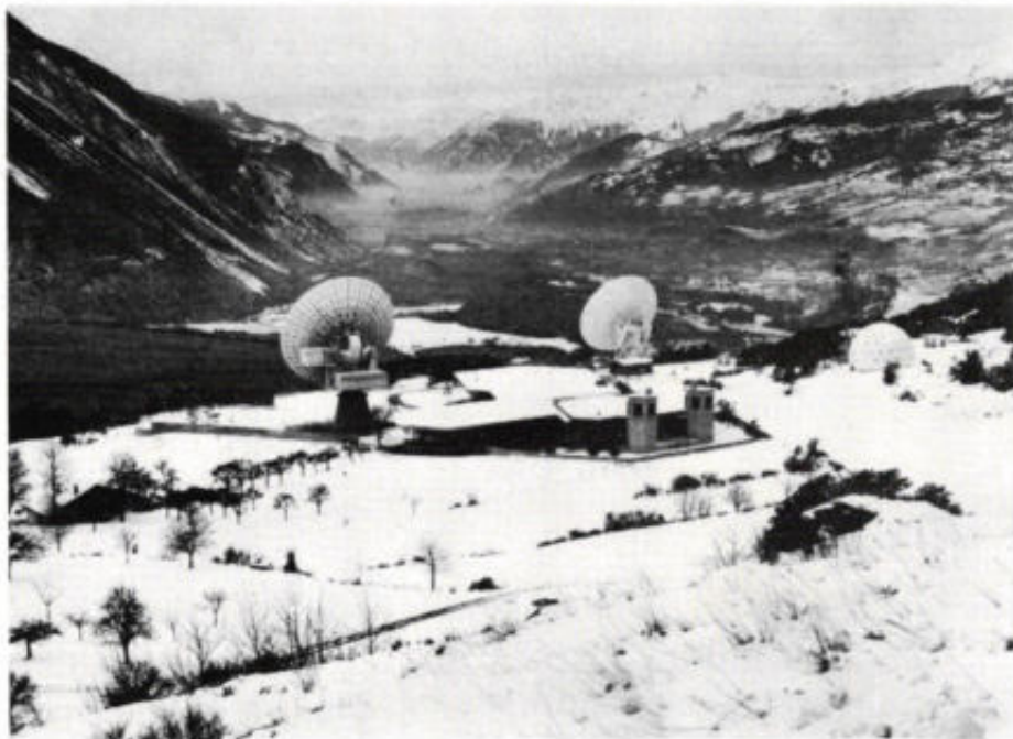
Afb. 1. Het Bodestation in Leuk (Zwitserland). Geheel rechts bevindt zich de eerste parabool, gehuld in een radome. Momenteel beschikt men van hieruit over 642 continue telefoon- en data-kanalen. Daarnaast maakt men voor Zwitserland gebruik van 144 kanalen in satellietverbindingen van buurlanden.
